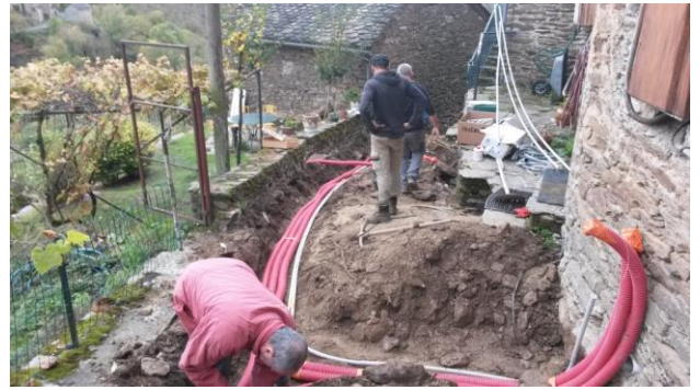
Pose des gaines électricité et téléphonie
