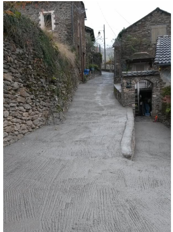
Rue de la préfecture avec son revêtement béton rénové
