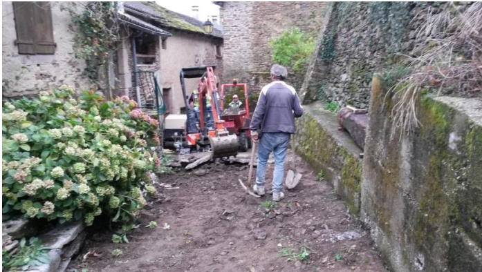
Rue de la préfecture, dépose du revêtement béton existant
