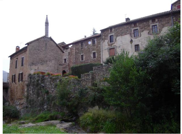
Vue arrière de la maison de Jean-Pierre Caylar avec la curieuse cheminée « lanterne des morts »
